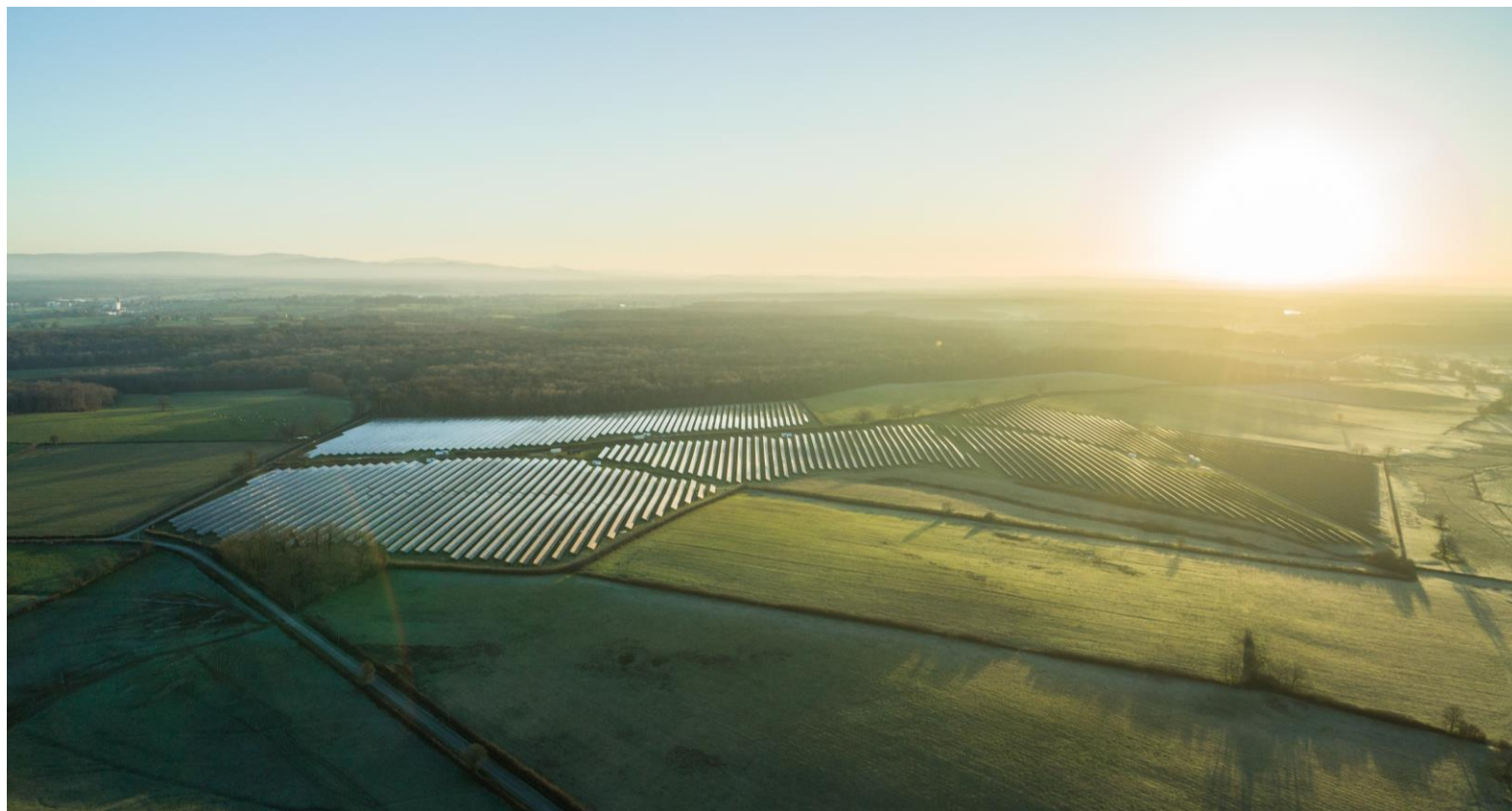
Centrale d'Ychoux-Parentis dans les Landes (43 MWc).
