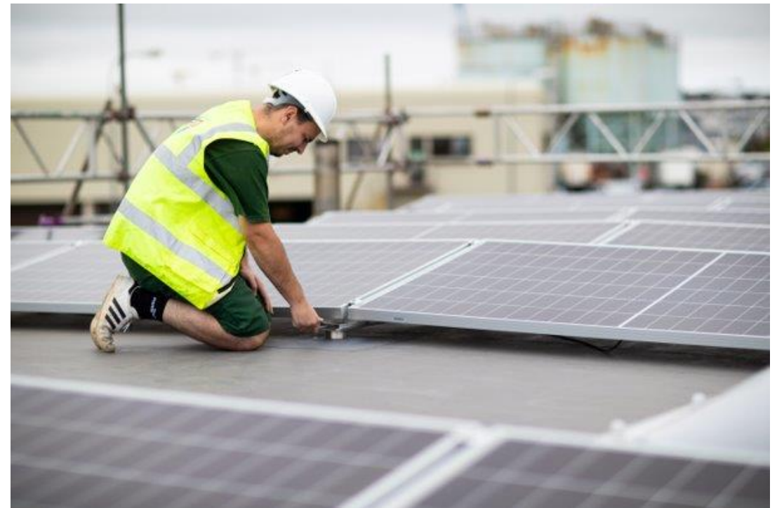
Installation de panneaux solaires chez un client GPL.
